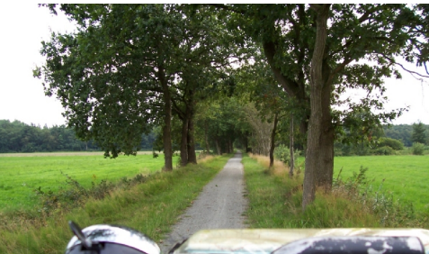
Trasse der stillgelegten Kleinbahn bei Aurich
