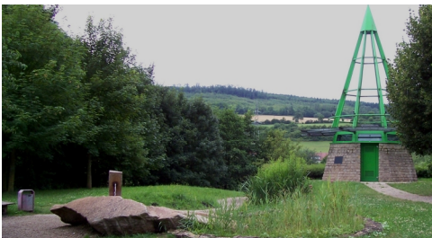
Brunnengebäude der Bietzemer Heilquelle
